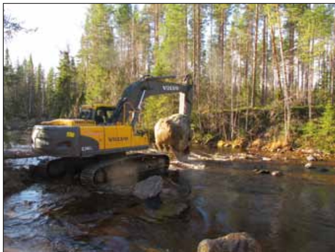
Stor sten har hämtats från land och placeras i vattendraget. Bilden är från Hjuksån nära Hällnäs inom Vindelns kommun. Foto: Stefan Ågren
